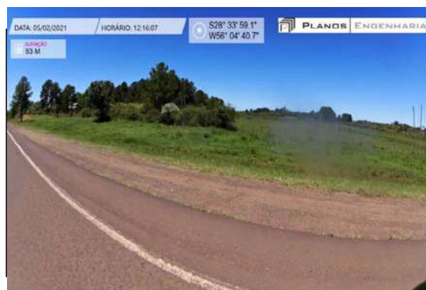
Km 0+000 - Pista lado direito - Cobertura vegetal gramínea e arbustivas
