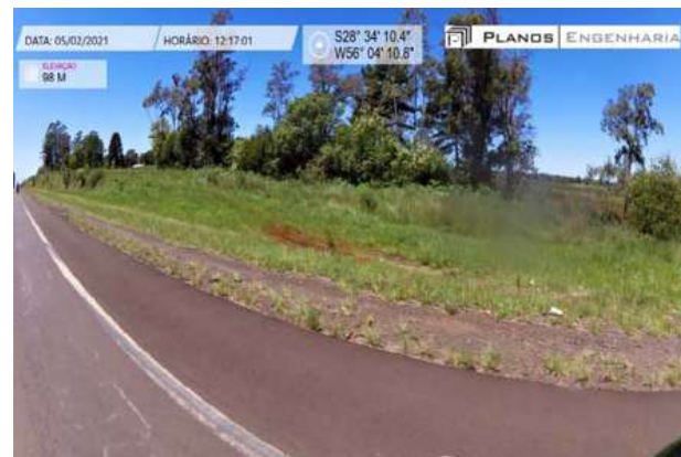
Km 1+000 - Pista lado direito - Cobertura vegetal gramínea e arbustivas
