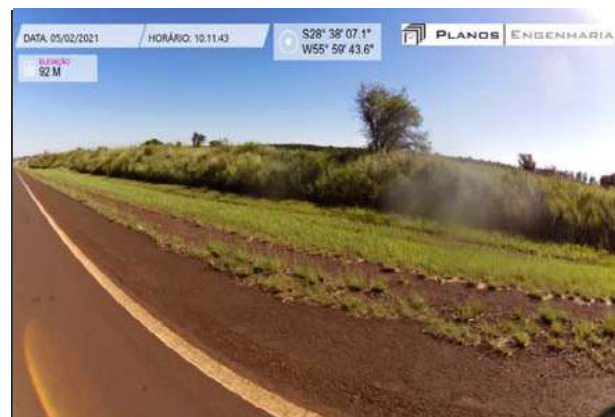
km 4+000 - Pista lado direito - Cobertura vegetal gramínea e arbustivas
