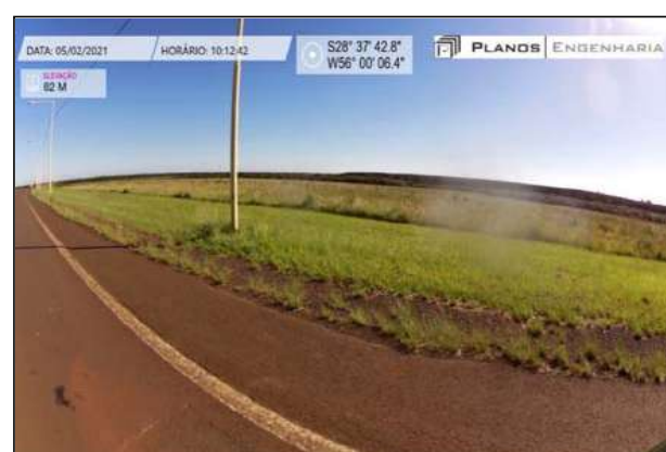
km 5+000 - Pista Lado direito - Cobertura vegetal gramínea
